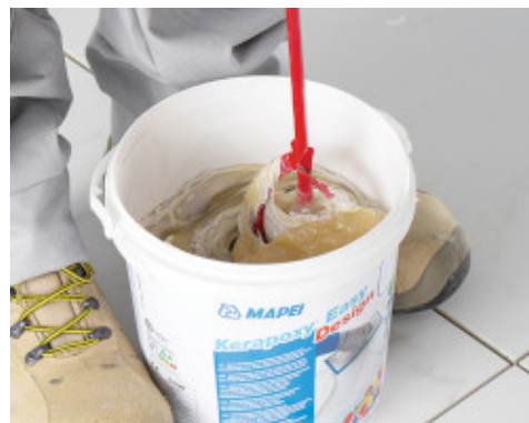
Разбъркване на компонентите (А+Б)
