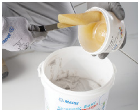
Изсипете втвърдителя (компонент Б) в съда с компонент А
